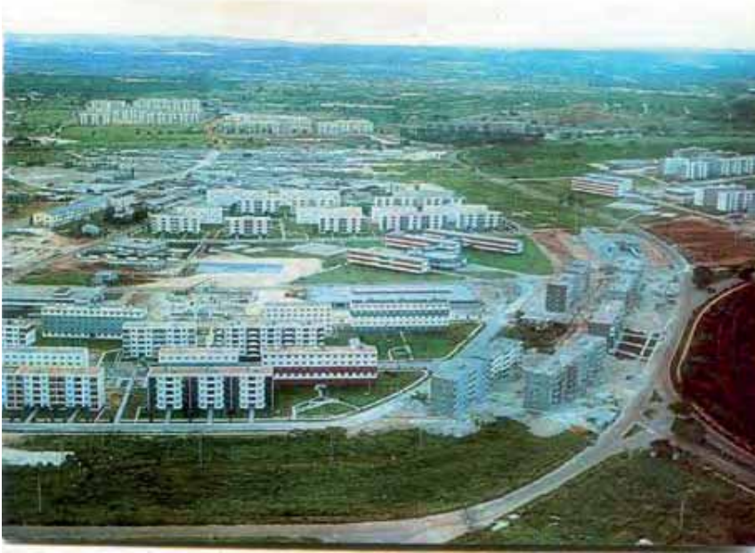
Vista aérea de la Zona 1, Habana del Este.
